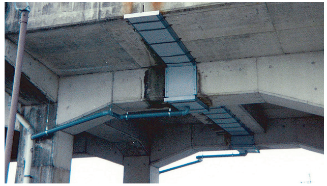
高架橋目地部
